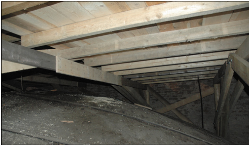
Instalace dřevěné konstrukce s podlážkou nad klenbou kostela.
