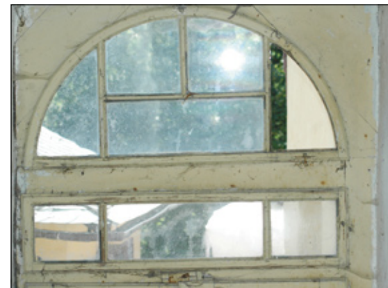
Obr. 11 Vletový otvor pro letní kolonii vrápence malého na půdě správní budovy Mladečských jeskyní (foto: Jiří Šafář).
