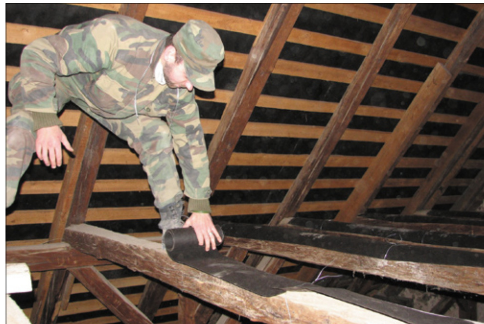
Obr. 33 Pokládání ochranných lepenkových pásů na trámy (foto: Martin Celuch).
