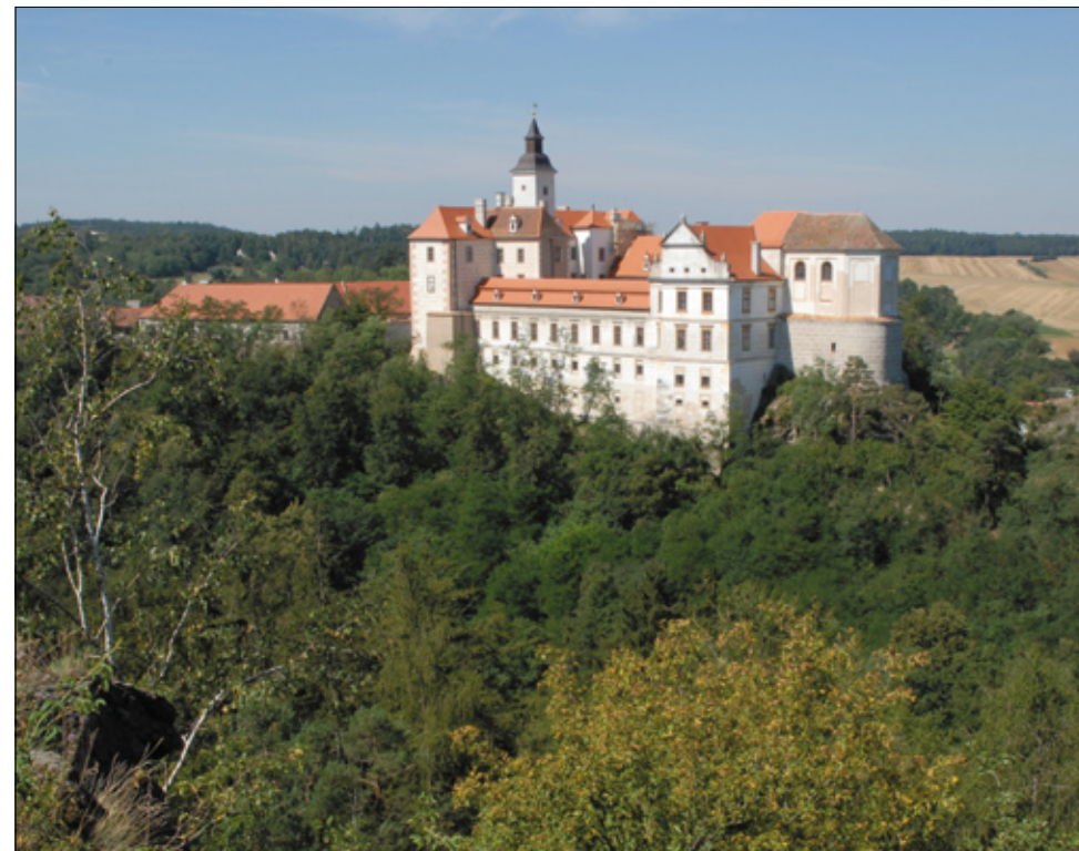
Pohled na střechy zámku po rekonstrukci. Na části budovy zcela vpravo je vidět ponechaná původní střešní krytina nad prostorem využívaným netopýry.
