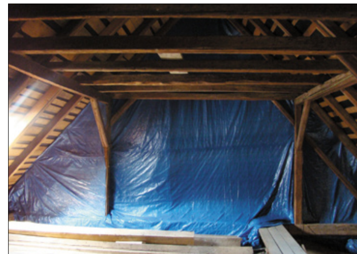
Obr. 9 Oddělení části podkrovních prostor využívaných netopýři pomocí plachty (foto: Martin Celuch).
