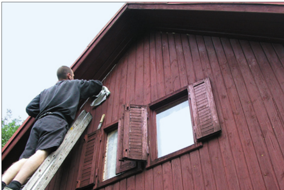
Čištění a zatmelení spáry nad okny.
