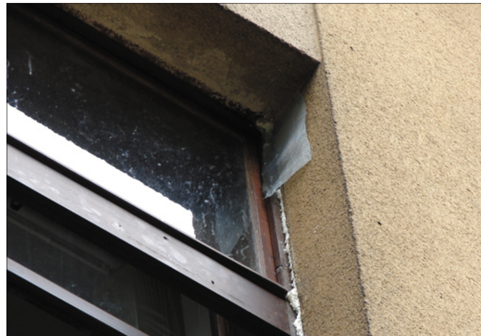
Obr. 17 Jednosměrná uzávěra štěrbinu pomocí jemné drátěné sítky (foto: Petra Schnitzerová).
