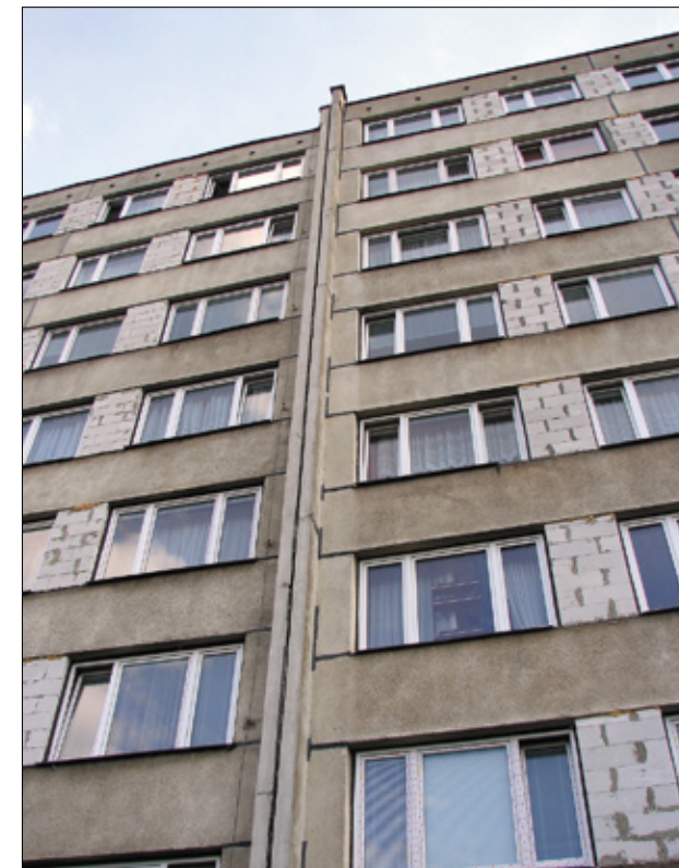
Panelový dům před zateplením.
