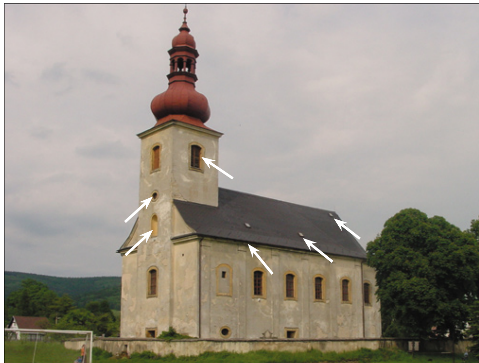
Obr. 10 Možné přístupové otvory na půdu kostela využívané netopýry (foto: Daniel Horáček).
