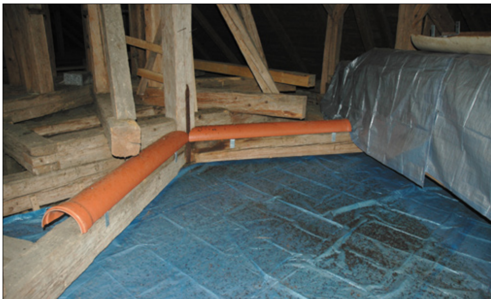
Ochranná fólie na podlážce následující rok po instalaci.
