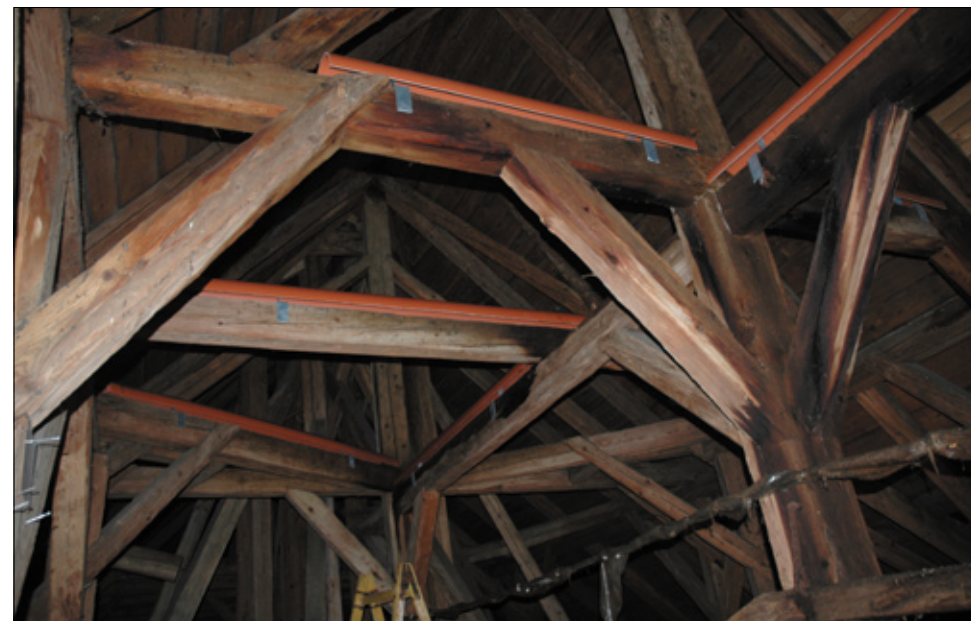
Ochranné stříšky z půlených trubek jako ochrana trámů.
