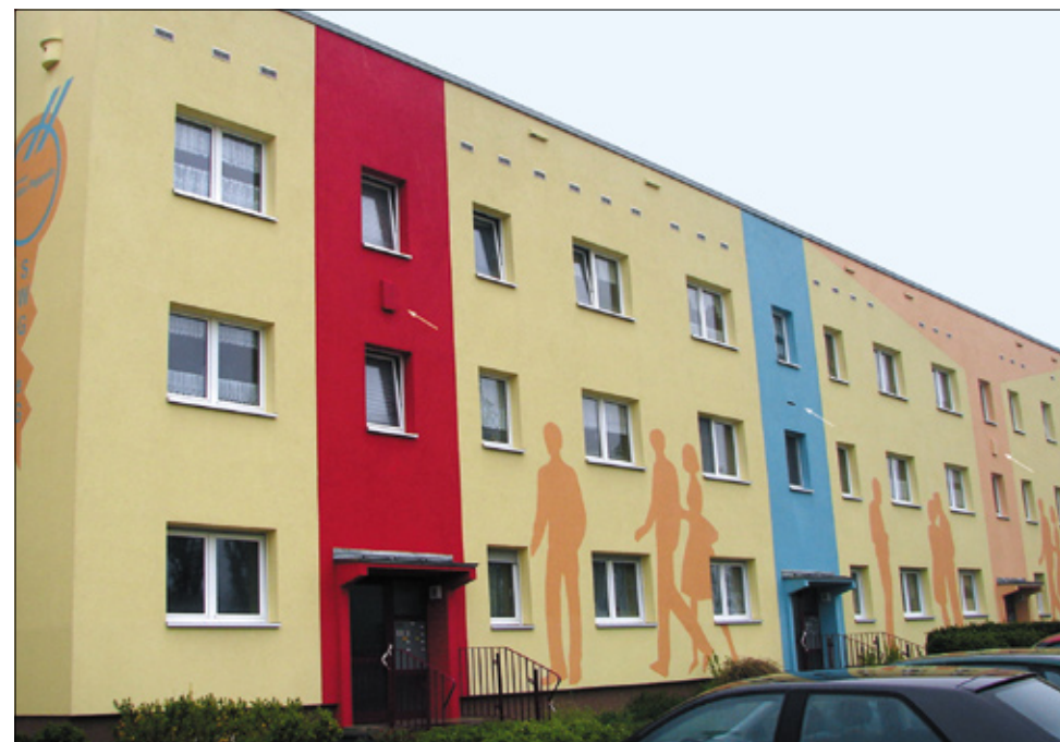
Obr. 24 Šipky ukazují umístění dvou typů budek pro netopýry na zatepleném panelovém domě ve městě Schmöln, Německo (foto: Petra Schnitzerová).
