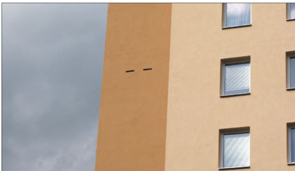
Bližší pohled na stěnu s budkami – patrné jsou pouze úzké vletové otvory.
