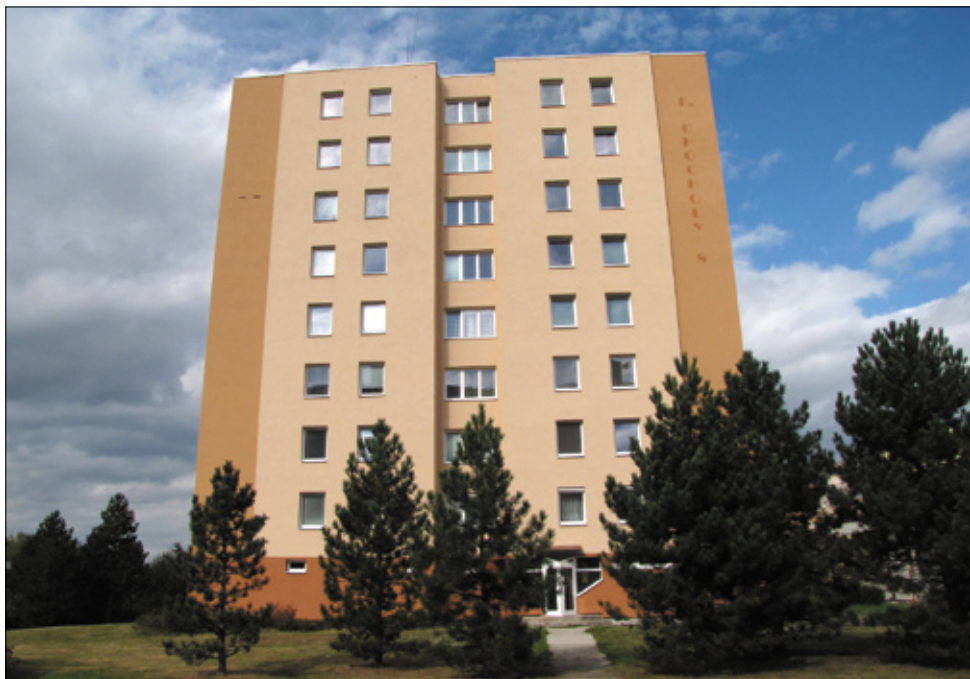
Zateplený panelový dům s instalovanými budkami.
