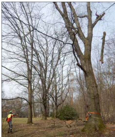
Postupné kácení a spuštění odříznuté části na laně, zámecký park Čechy pod Kosířem (foto: Evžen Tošenovský).
