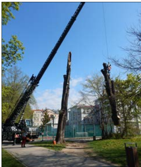
Postupné kácení pomocí autojeřábu, Olomouc – Čechovy sady (foto: Evžen Tošenovský).
