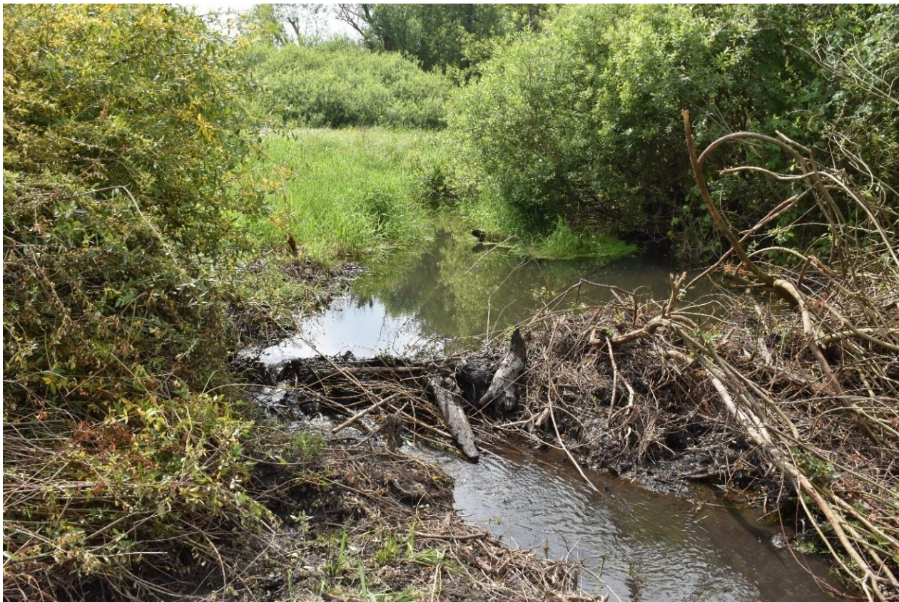
PR Koutské a Zábřežské louky – provizorní přehrážka melioračního kanálu z nahrnuté zeminy. 29.5.2024
