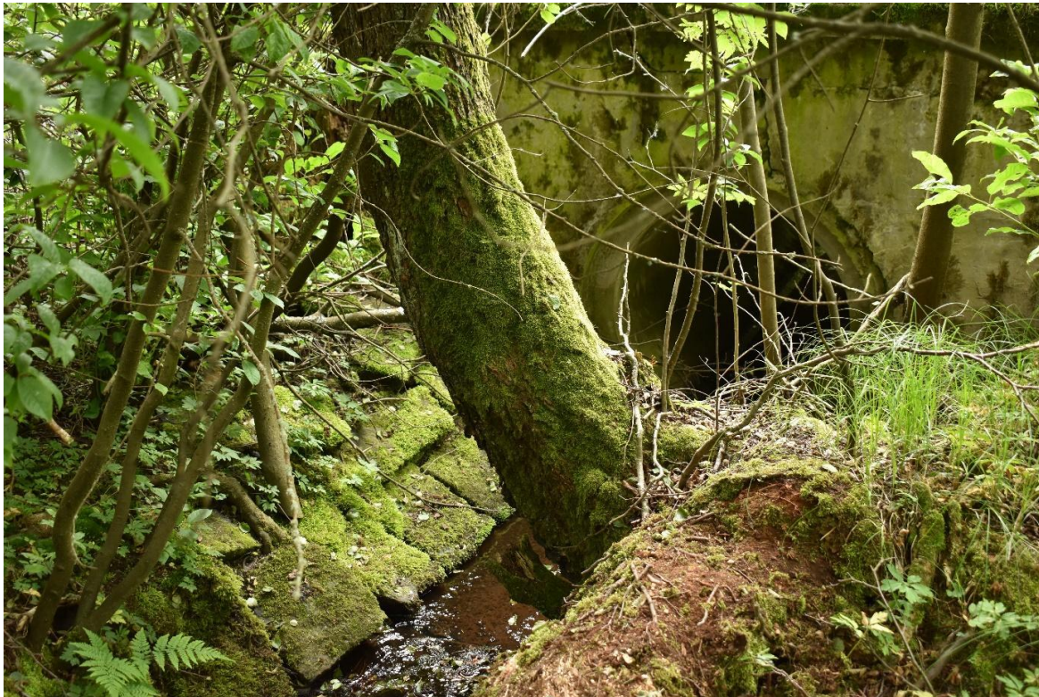
PR Mokřiny u Krahulčí – propustkem pod cestou vytéká potok z rezervace, regulovatelným zahrazením propustku je násep cesty možno využít jako hráz pro zadržení vody ve spodní části lokality. 30.5.2024
