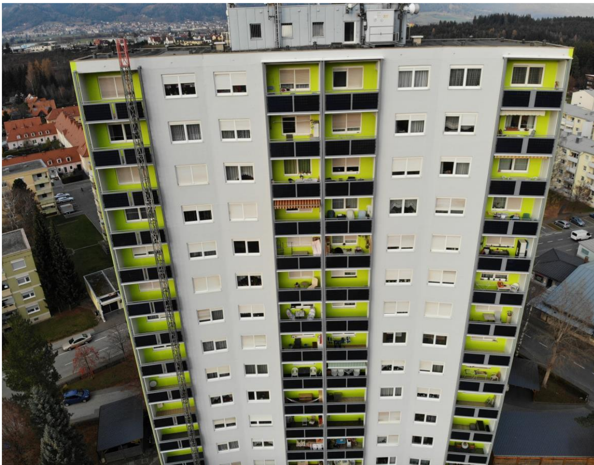
Obrázek 23 - Realizace fasádních fotovoltaických panelů na balkonech bytového domu v Judenburgu
