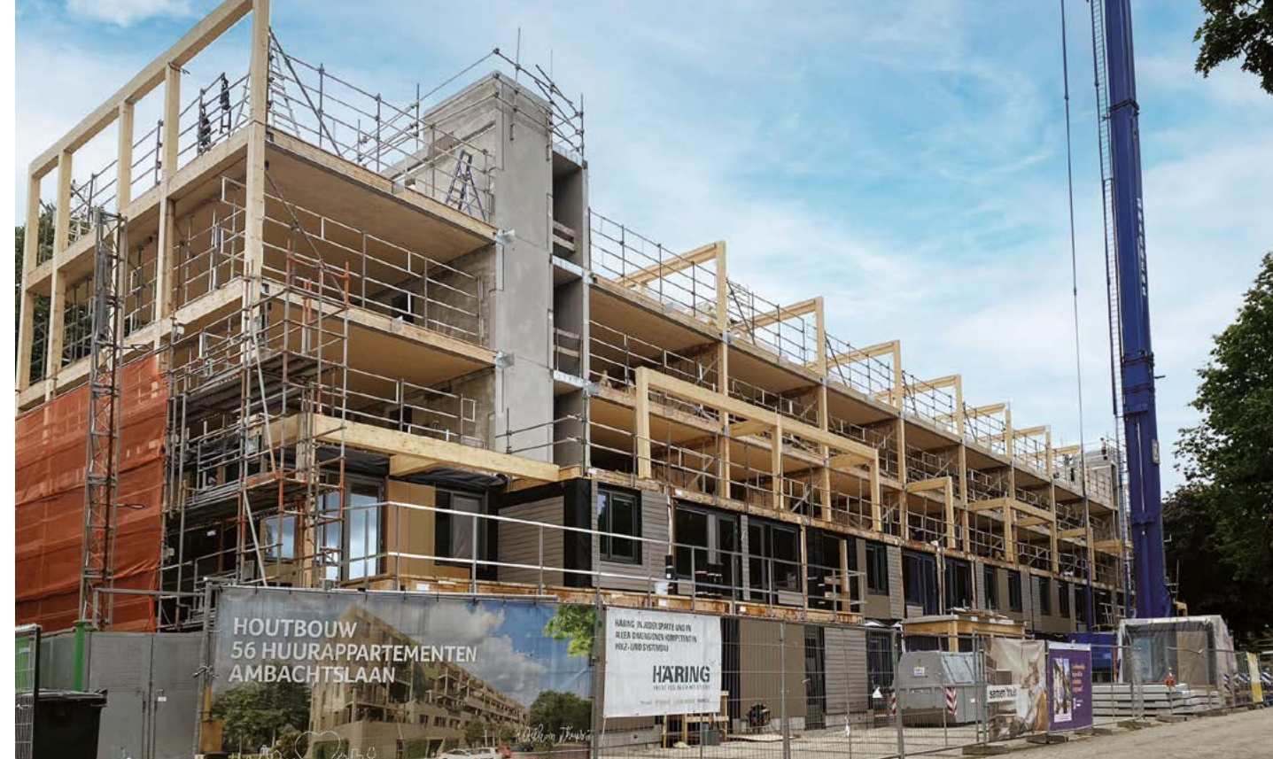
Výstavba bytového domu
