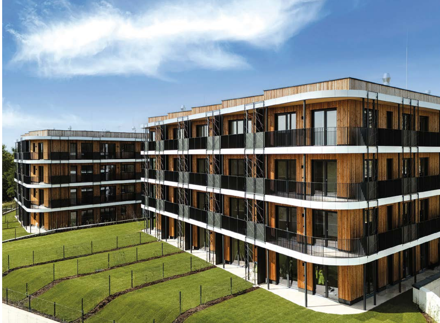
Dva čtyřpodlažní bytové domy v rámci projektu Timber Praha
