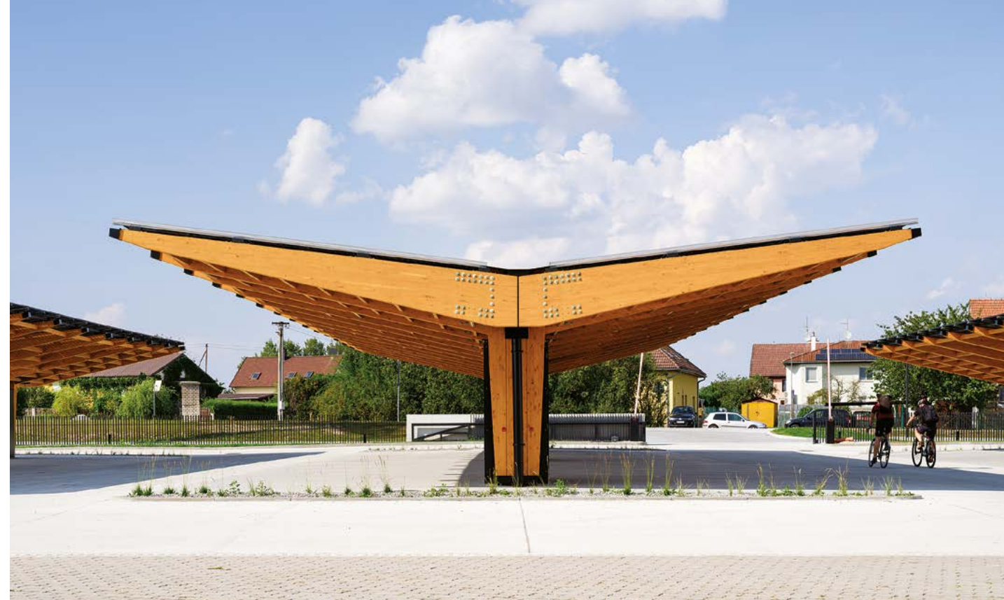
Dřevěné přístřešky parkovacích stání mají střechy pokryté fotovoltaickými panely
