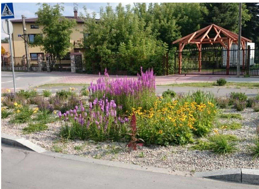
Obr. P3. 3. Ukázka zeleného opatření pro HSV – dešťová zahrada, v rámci které jsou přirozeně zasakovány srážkové vody z přilehlých komunikací (Varšava - Marki, Polsko, 2017) – Fotoarchív autora
