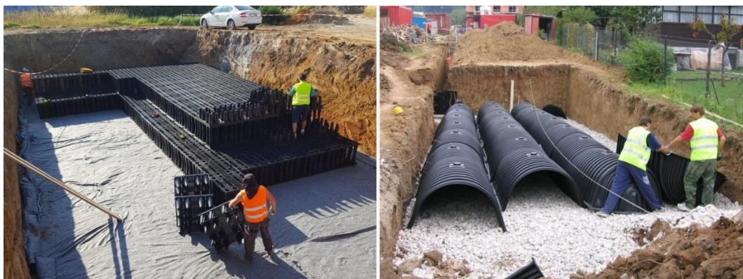
Obr. 2. 12. Vsakovací boxy (vlevo) a vsakovací tunely (vpravo) – Archív autora
