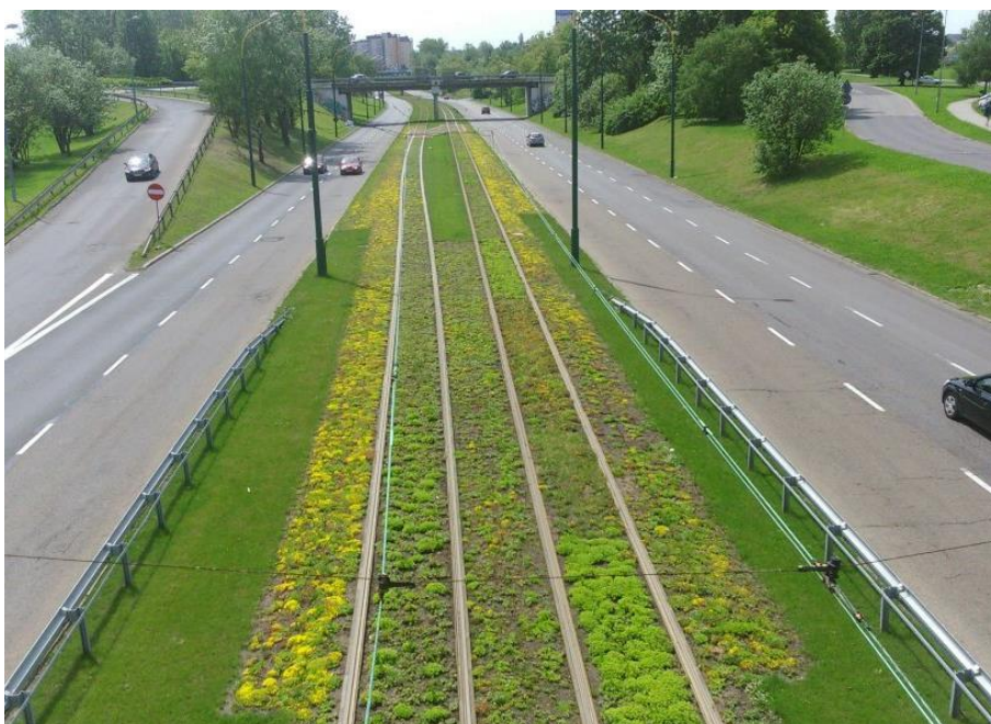
Obr. P3. 4. Aplikace zelených opatření v rámci tramvajového pásu, který je částečně dotován srážkovými vodami z přilehlých místních komunikací (Katovice - Sosnovec, Polsko, 2018) – Fotoarchív autora
