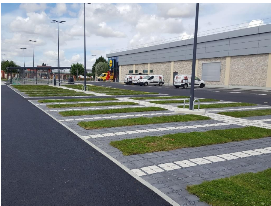
Obr. 2. 16. Aplikace zelené infrastruktury – zelené parkování u obchodního domu Lidl (Salzburg, Rakousko, 2019) – Archív autora
