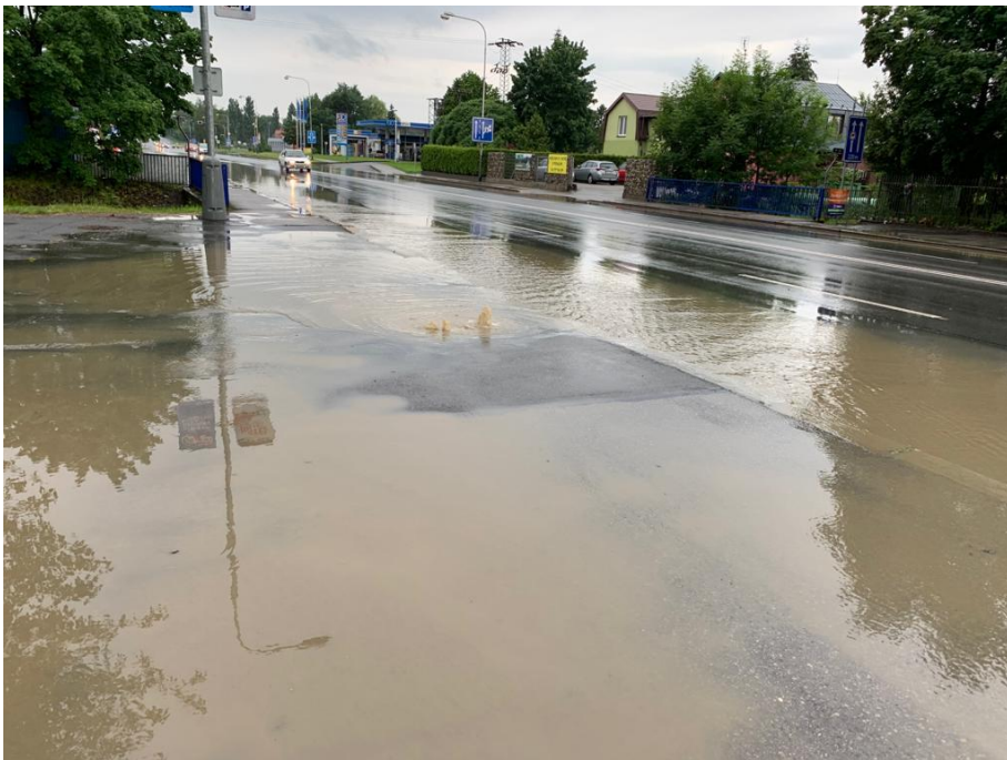
Obr. P1. 1. Bleskové povodně v urbanizovaném území města, přívalové srážkové vody vyvěrají z jednotné kanalizační sítě na povrch (ul. Ostravská, Karviná, 2019) – Fotoarchív autora
