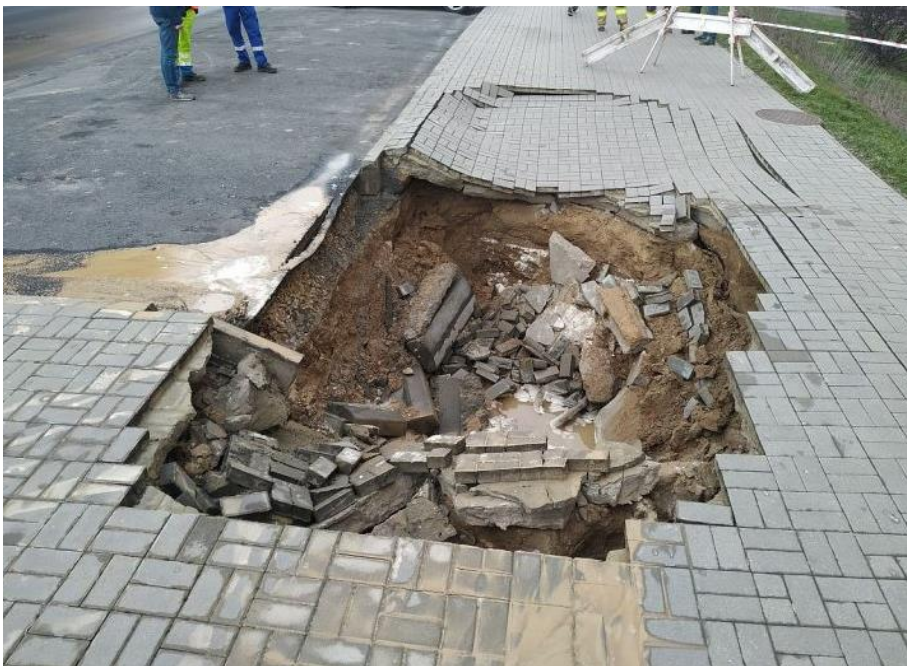
Obr. P3. 2. Veřejná stoková soustava v havarijním stavu byla narušena vlivem přívalových vod, které vyplavily zeminu v okolí potrubí a podemlely chodník pro pěší (Lublin, Polsko, 2020) – Fotoarchív autora
