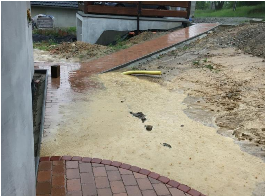
Obr. P3. 5. Přívalové srážkové vody stékají z veřejného uličního prostoru díky absenci stokového systému, případně dalších úprav pro HSV na soukromé pozemky (Karviná - Ráj, 2020) – Fotoarchív autora
