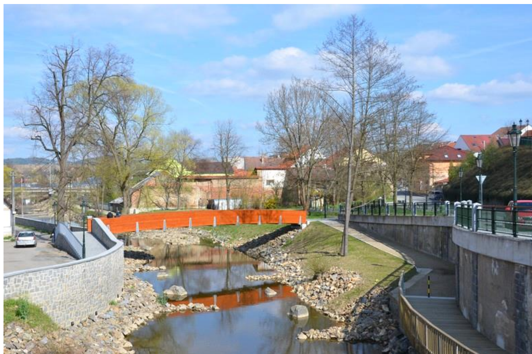
Obr. 1. 6. Přírodě blízké a povodňově kapacitní řešení potoka. (potok Blanice, Vlašim, 2018) – Archív autora
