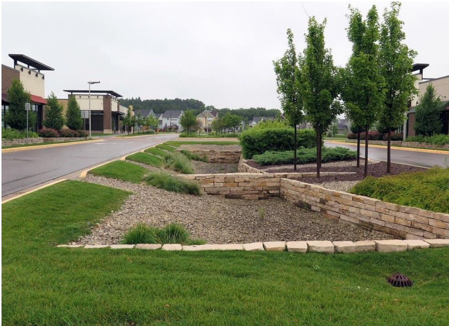
Obr. P3. 5. Ukázka vsakovacího příkopu s akumulčním prostorem pro srážkové vody z přilehlých komunikací, vpravo dole je viditelný bezpečnostní přepad do veřejné stokové sítě - Mineapolis, USA (MPR.news)
