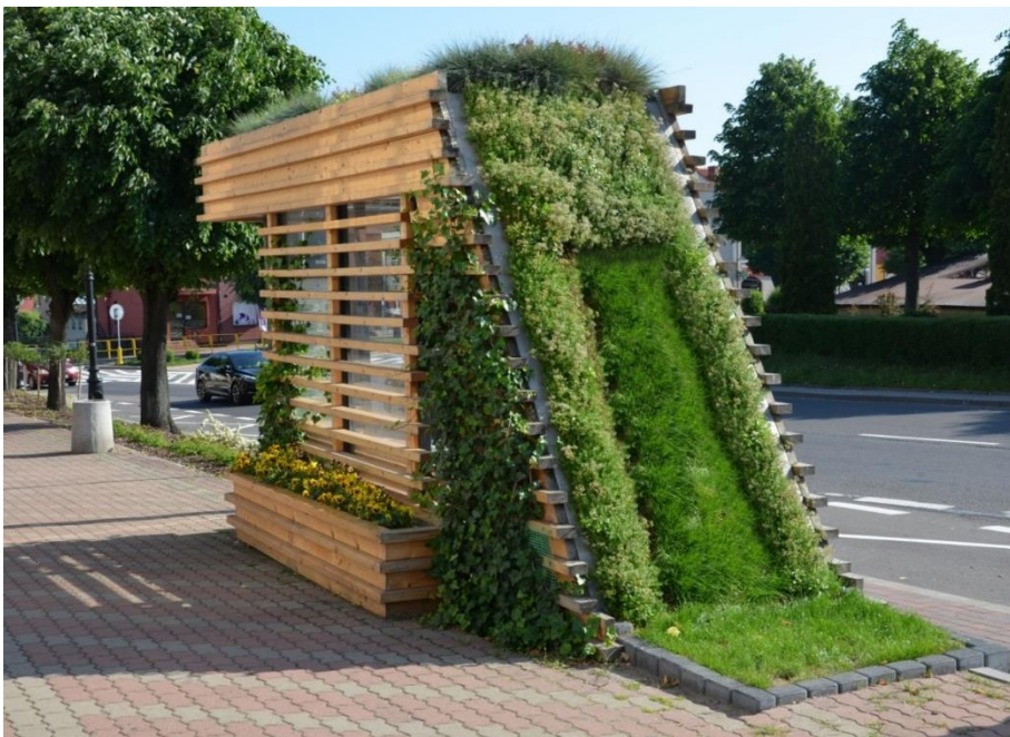
Obr. P3. 2. Zelená autobusová zastávka, vegetační střeška a stěna - zavlažováno srážkovými vodami, které dopadají na daný povrch (Siemiatycze, Polsko, 2018) – Fotoarchív autora
