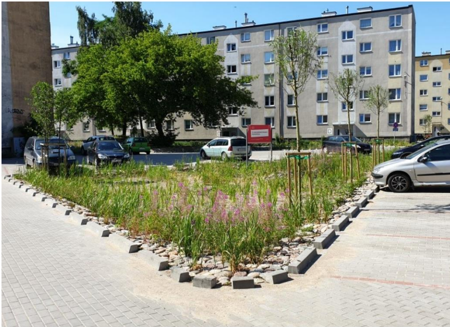
Obr. P3. 1. Ukázka využití dešťové zahrady jako zelené opatření pro přirozené vsakování srážkových vod odváděných z parkovacích stání uvnitř bytového vnitrobloku (Gdaňsk, Polsko, 2019) – Fotoarchív autora
