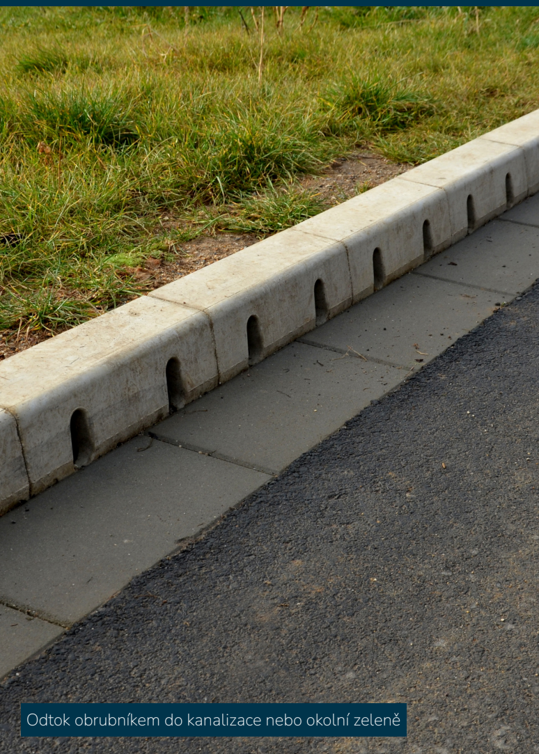
Odvodňovací žlab
