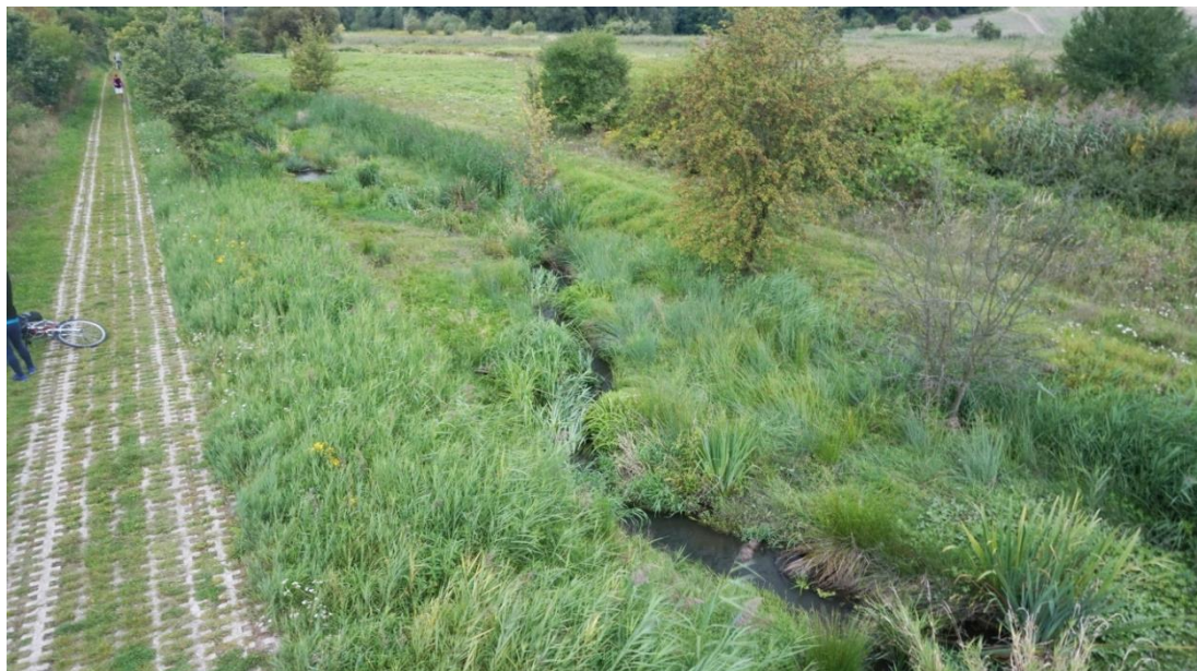
Revitalizace Svěpravického potoka v k. ú. Hostavice (zdroj: VÚV TGM, v.v.i.)
