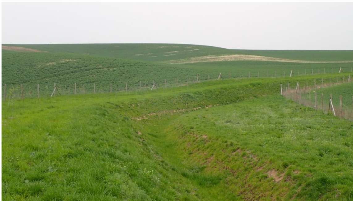
Nově realizovaná meze s příkopem v k.ú. Němčany (okres Vyškov) (zdroj: VÚV TGM, v.v.i.)
