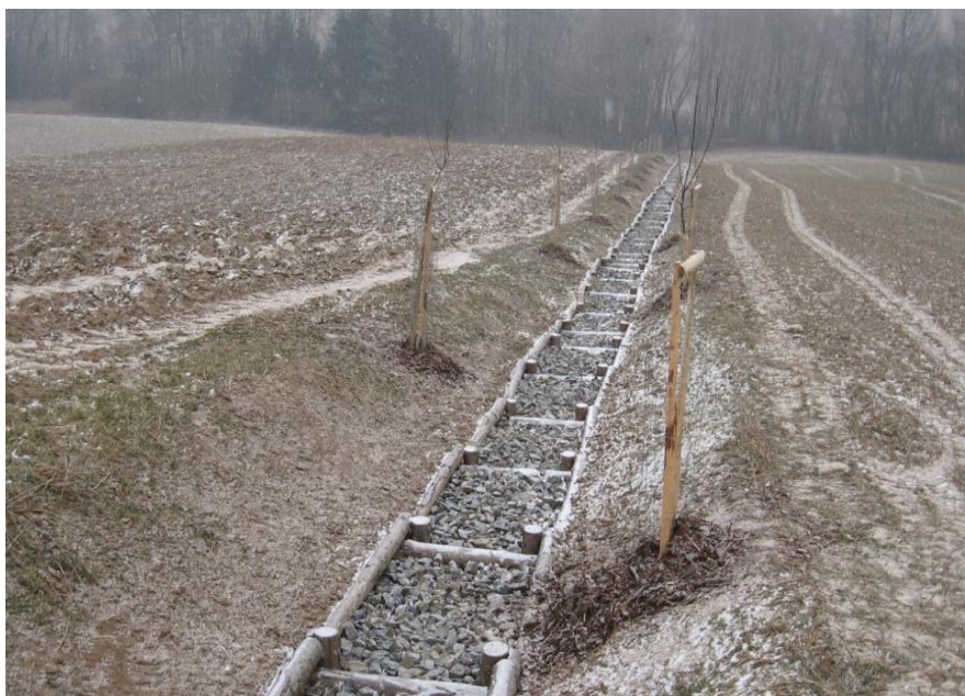
Svodný zpevněný příkop v k.ú. Lhotka u Zlína (okres Zlín)(zdroj: VÚV TGM, v.v.i.)
