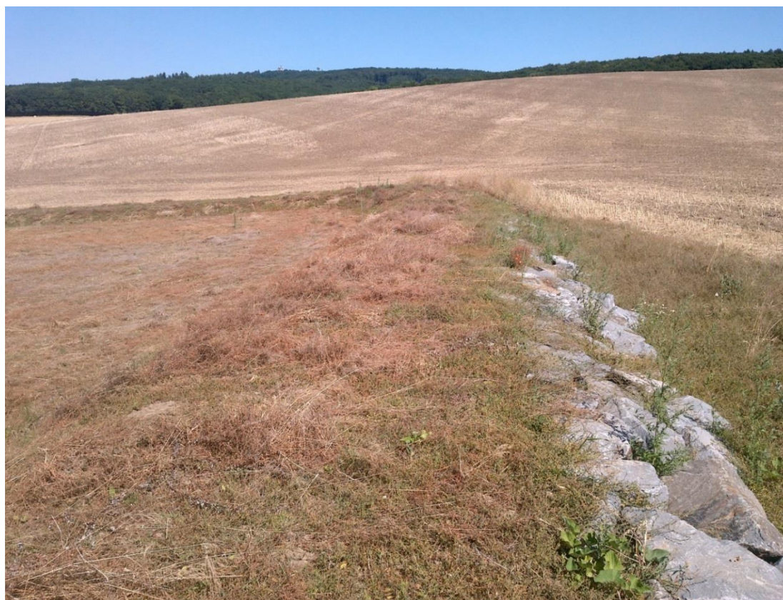
Opevněná hrázka v k.ú. Nemochovice (okres Vyškov) (zdroj: VÚV TGM, v.v.i.)
