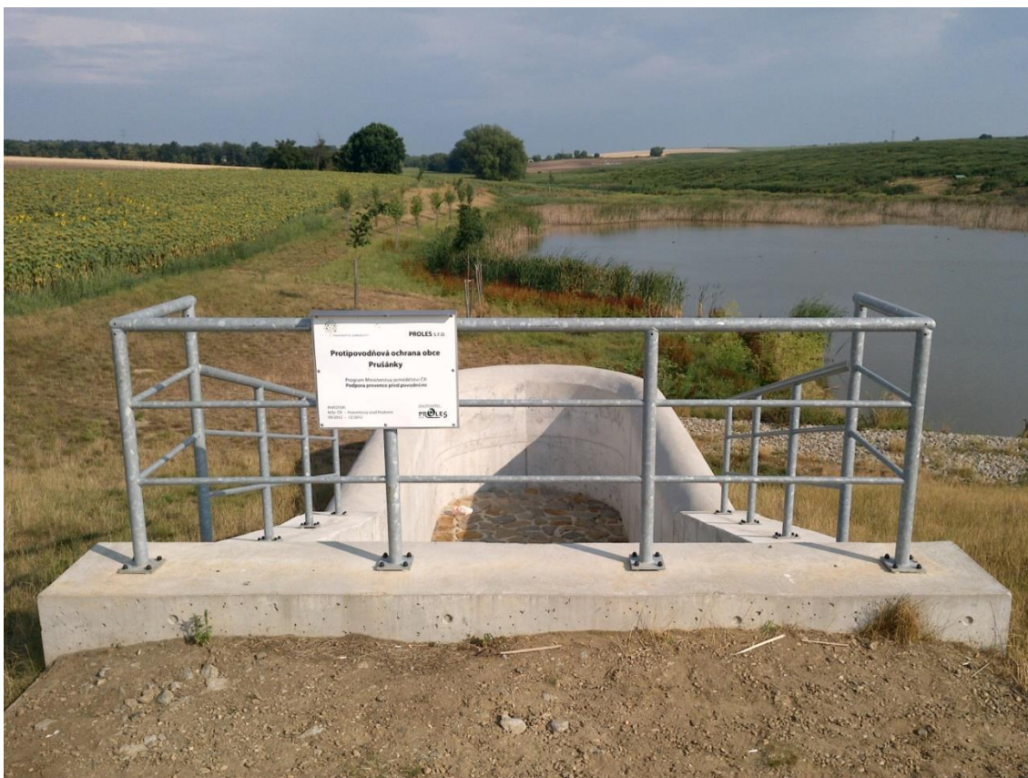
Retenční nádrž s částečným zásobním prostorem s kašnovým bezpečnostním přelivem v k.ú. Prušánky (okres Hodonín) (zdroj: VÚV TGM, v.v.i.)
