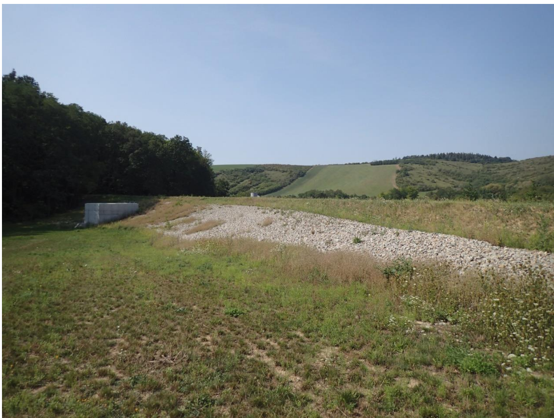
Suchá retenční nádrž "Pod Lipinami" se sdruženým funkčním objektem v k.ú. Kurdějov (okres Břeclav) (zdroj: VÚV TGM, v.v.i.)
