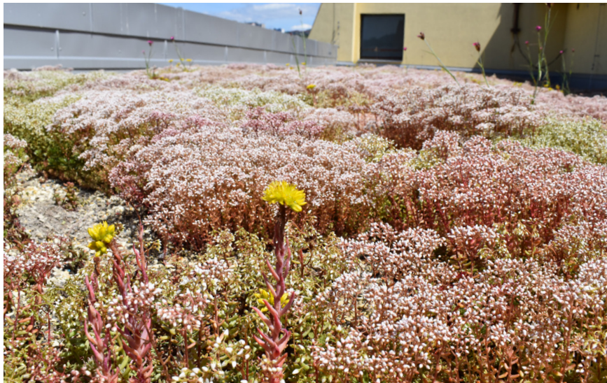
Pohled na zelenou experimentální střechu v červnu 2022, Zdroj: autoři
