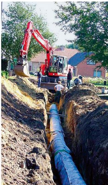
Výstavba podzemního vsakovacího objektu
