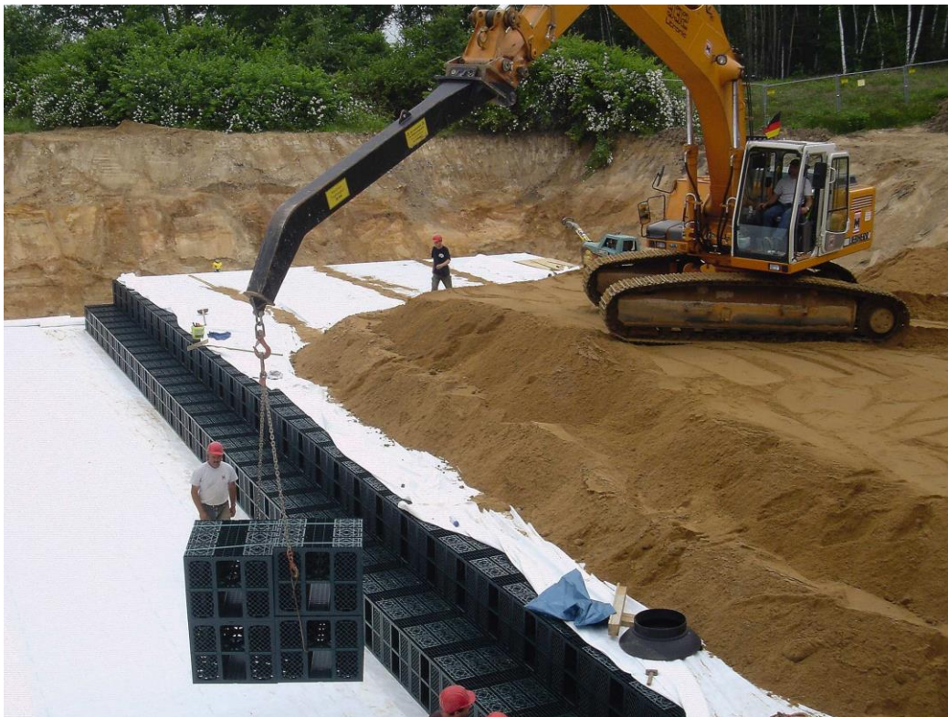
Výstavba vsakovacího objektu z platových košů
