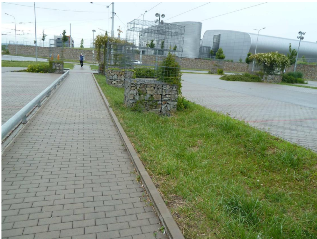
Průleh mezi komunikacemi
