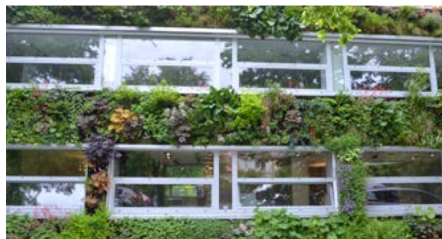
Obrázek 70: Bezsubstrátový systém v létě
