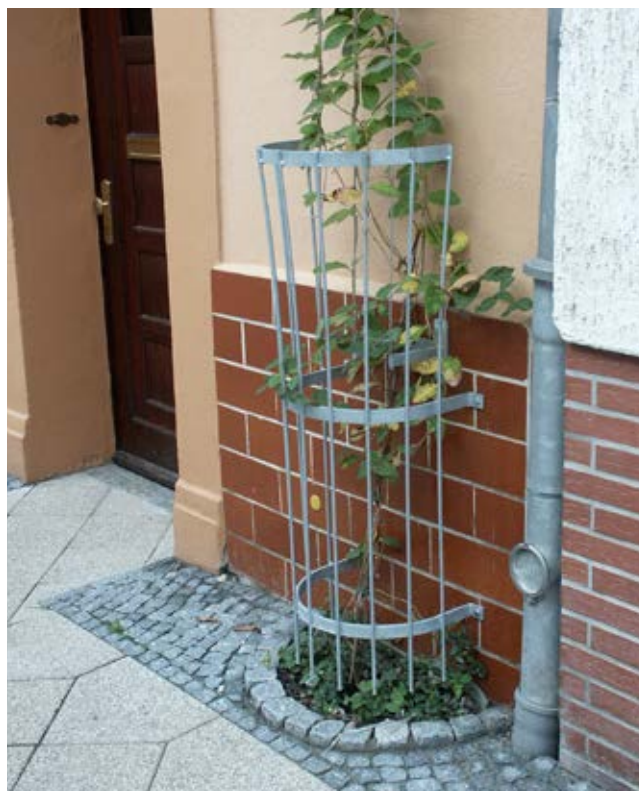
Obrázek 25: Ochrana pnoucích dřevin mříží
