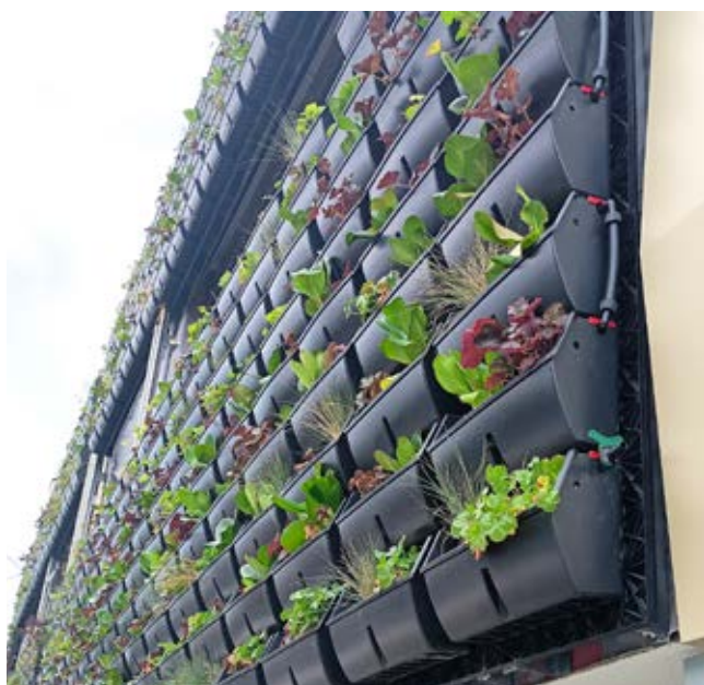
Obrázek 68: Korytový systém
