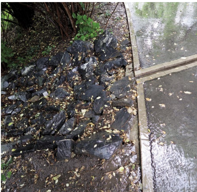
Obr.74: Směřování toku vody z chodníku do kamenné kaskády pomocí žlábků
