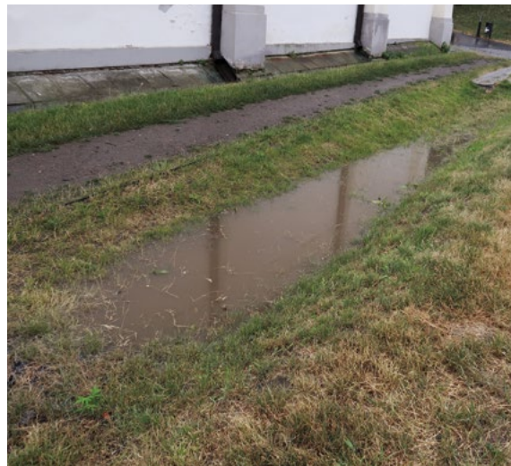
Obr.76: Zasakovací průleh naplněný vodou po dešti
