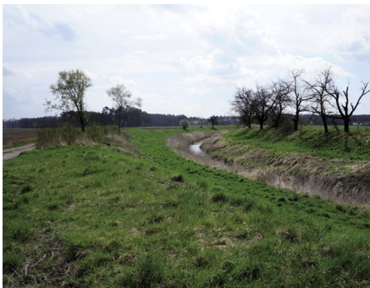
Obr.21: Technická úprava řeky Výrovka v Kostelní Lhotě
