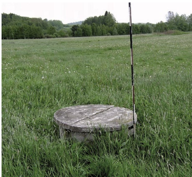
Obr.22: Drenážní šachta nad zatrubněným potokem
