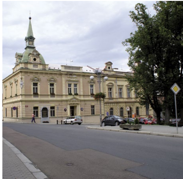
Obr.27: Plochy komunikací - dešťová voda odtéká do kanalizace
