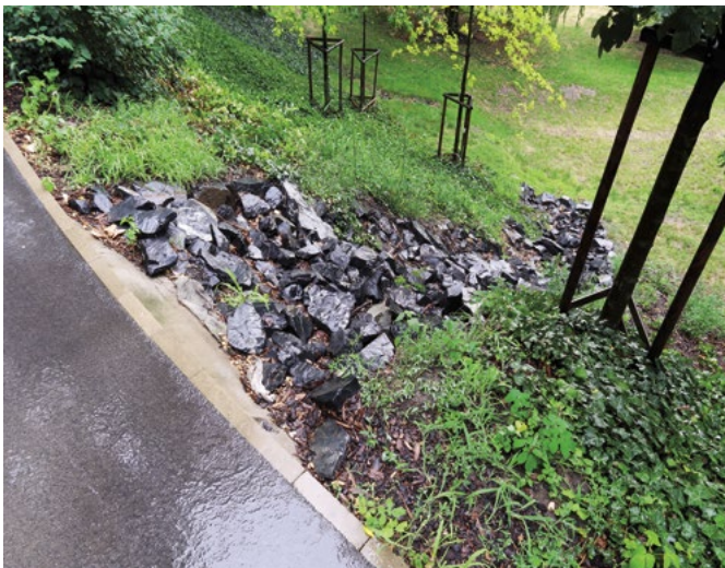
Obr.75: Kamenná kaskáda zpomalující odtok vody v prudkém svahu
