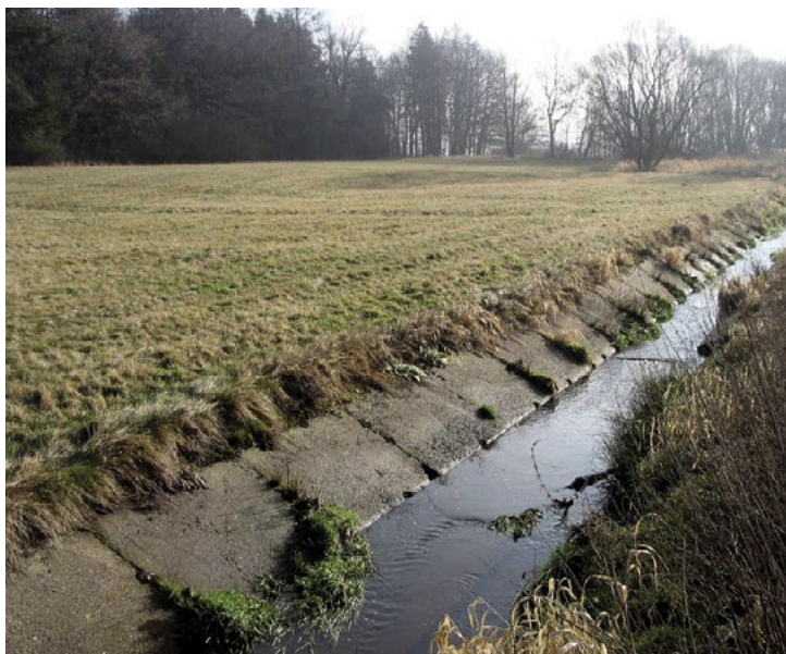
Obr.20: Technická úprava toku
