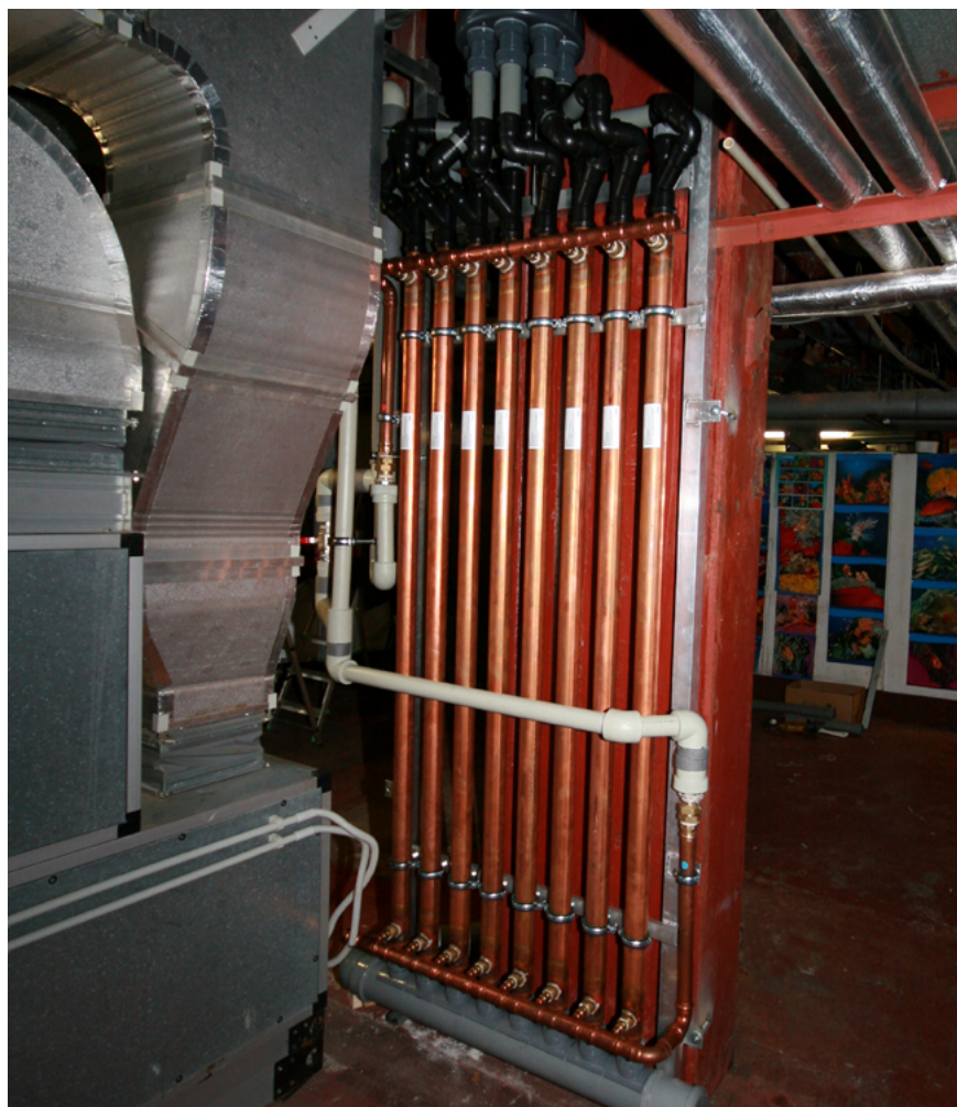
Obrázek 16: Rekuperační výměník
