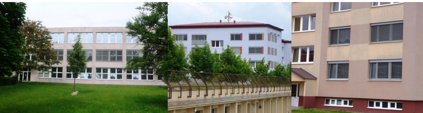
Stínící prvky v Uherském Hradišti
