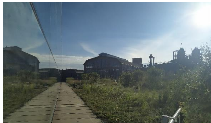
Zelená střecha roku 2016 – STC Ostrava, Dolní Oblast Vítkovice
