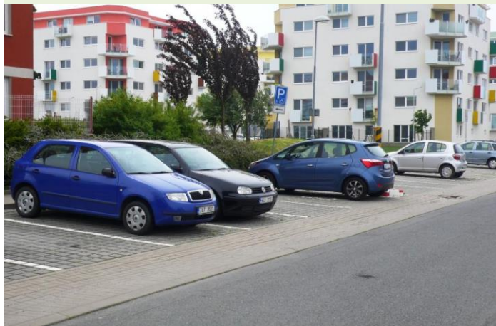
Parkovací stání s propustným povrchem u O-City, Uherské Hradiště
