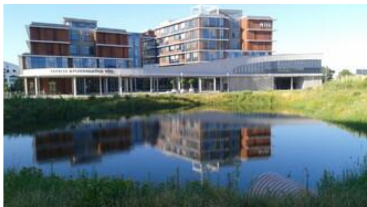
Povrchová retenční nádrž v univerzitním areálu ZČU Plzeň a obytný komplex UniCity, Zdroj: Jan Kopp, 2020, Ekolist
