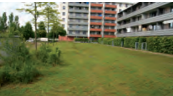
Obr. 22 Zasakovací průleh a zatravněvací plastová dlažba, Mnichov-Riem (zdroj: Veronika Kalníková)
