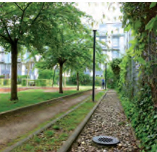
Obr. 23 Štěrková retenční rýha a detail odvodnění parkoviště, Mnichov-Riem (zdroj: Zdenka Kovářiková)
