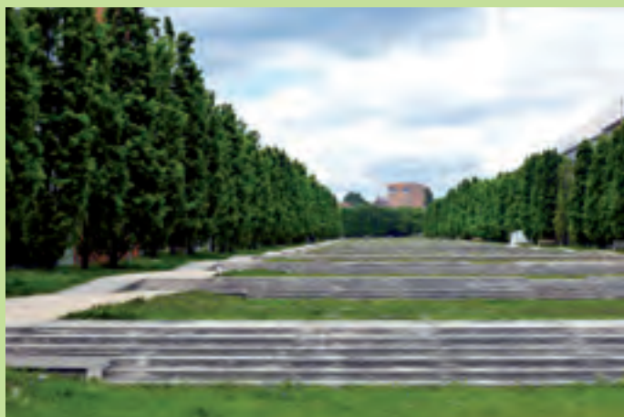
Obr. 26 Kaskáda průlehů určených pro plošné vsakování, Stuttgart (zdroj: Zdenka Kovářiková)
