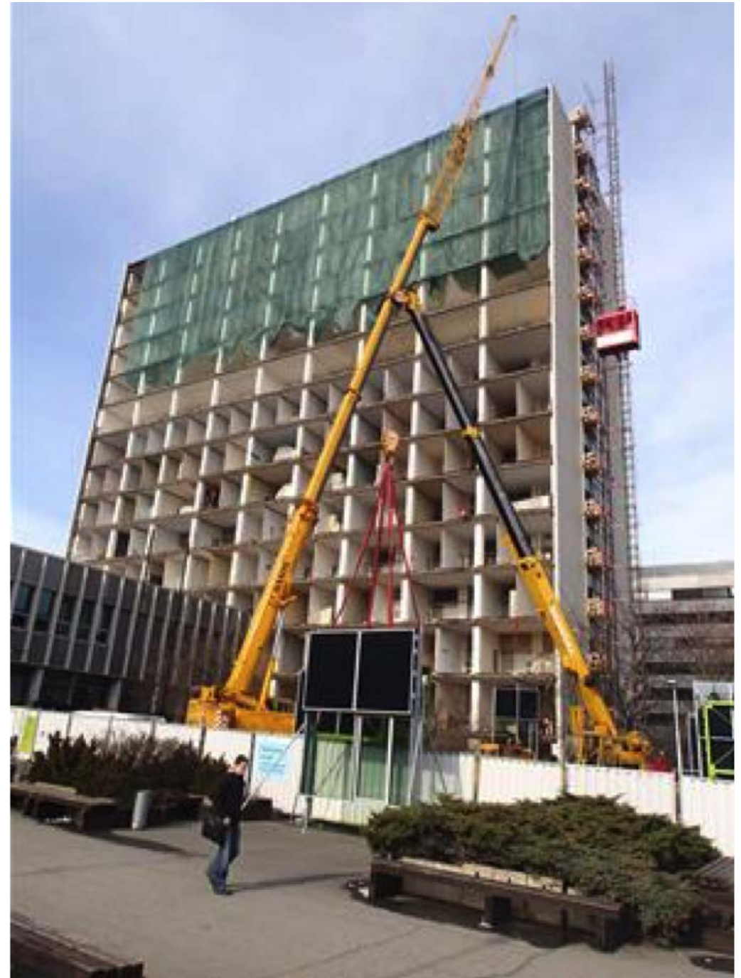
Výměna obvodového pláště budovy A Stavební fakulty ČVUT, Zdroj: Skanska
