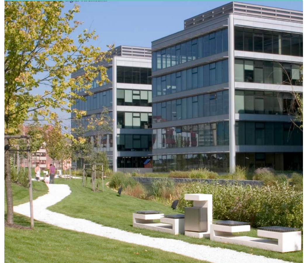
Administrativní areál The Park , Chodov, Praha, Zdroj: Peter Bednár
