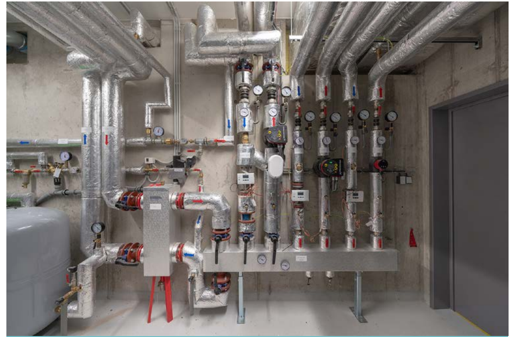
Systém vzduchotechniky na projektu Červený dvůr, Zdroj: JRD
