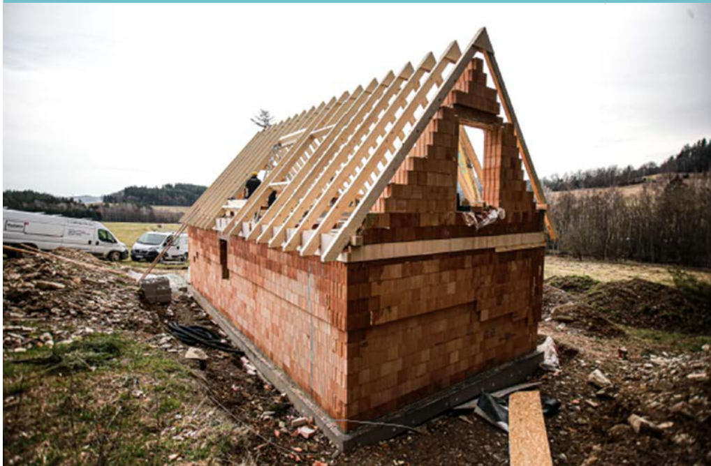
Výstavba Českého soběstačného domu, Zdroj: Pavel Podruh
